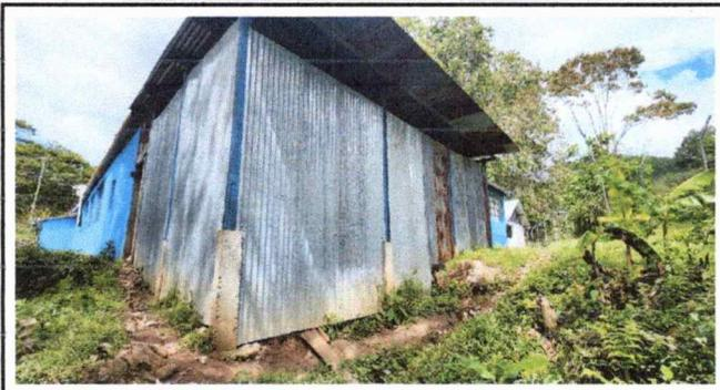
FOTO 7: Reparación de muro merimetal y de columnas
