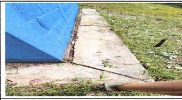
FOTO 6 : Reparación sustitución de piso de concreto
