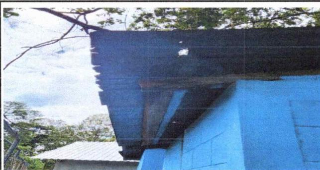
FOTO 15: Sustitución canales y lamina troquelada
