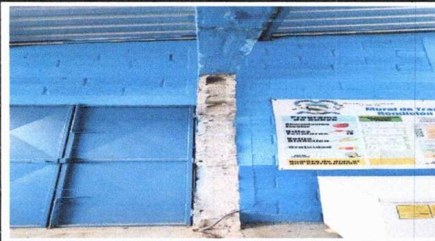
FOTO 3: Reparación de columnas
